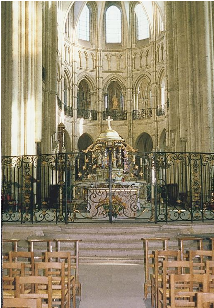
Intérieur de la Cathédrale de Noyon Clôture du chœur - ferronneries du XVIIIème siècle
